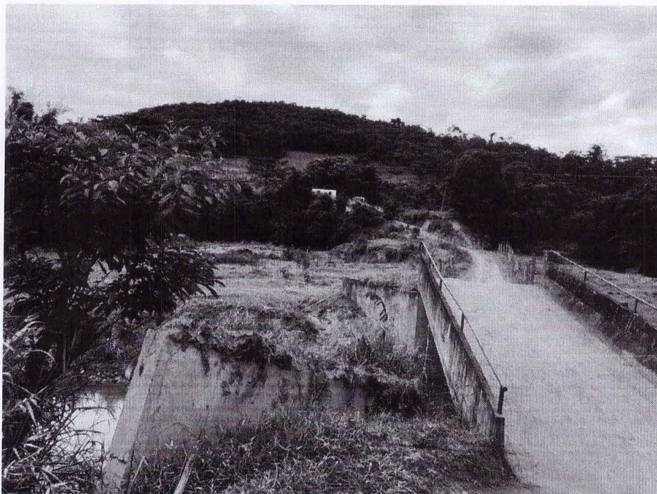
Foto 03: Mostra o acesso que a ponte fazia a propriedades rurais.
